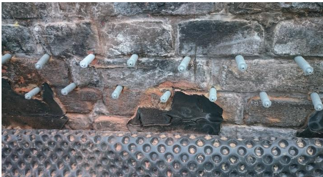
Otwory przygotowane do iniekcji dwurzędowej.
