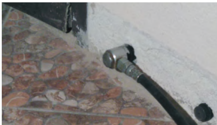
Aplikowanie środka w systemie niskociśnieniowym.
