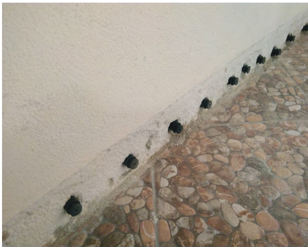
Przygotowanie ściany do iniekcji jednorzędowej – pas uszczelniający z Kombi Hydro Stop oraz wykonanie odwiertów.
