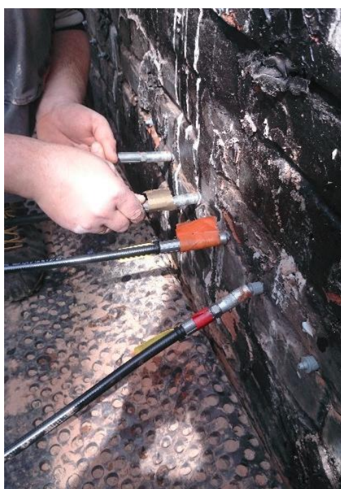
Prace przygotowawcze do aplikacji preparatu za pomocą agregatów.
