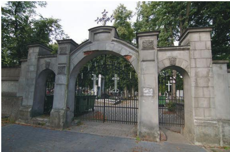
Widok bramy nr 1 przed i po remoncie.
